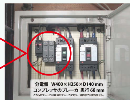
2台の電力マルチタンシマルを設置
