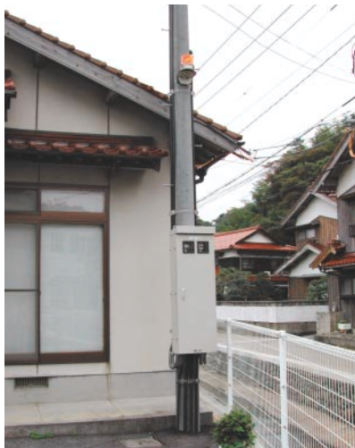
図4 マンホールポンプ制御盤
