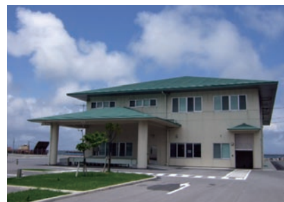
図3 余水処理施設
