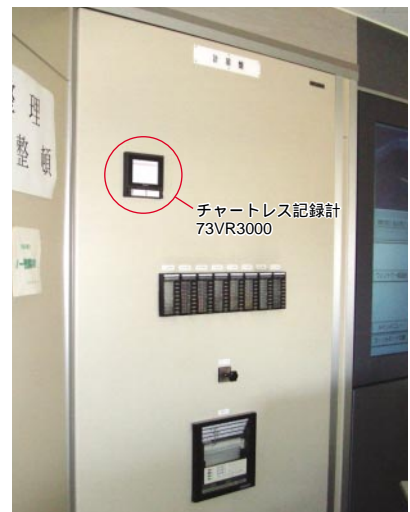
図3 計装盤に設置されたチャートレス記録計(形式:73VR3000)
