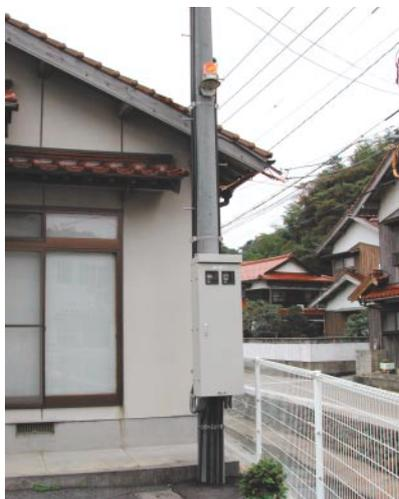
図4 マンホールポンプ制御盤
