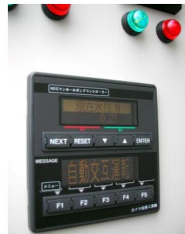
図3 パネル取付け形コントローラ
