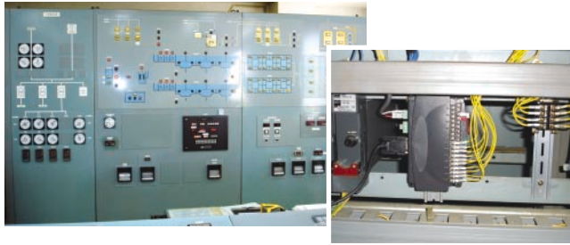
図2 藤井浄水場にある監視盤と盤内に設置されたPCレコーダ
